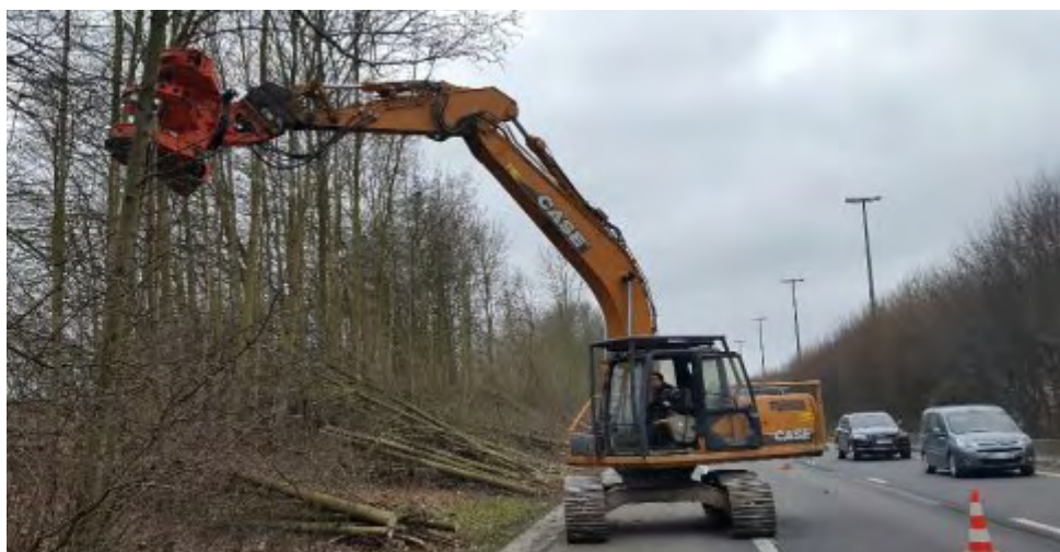
Chantier d'abattage en bord d'autoroute, photo Laurent Debarge
